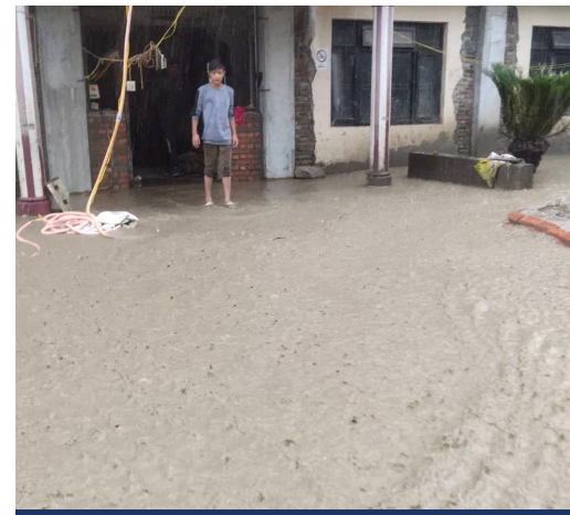
Vannet har fylt første etasje.
