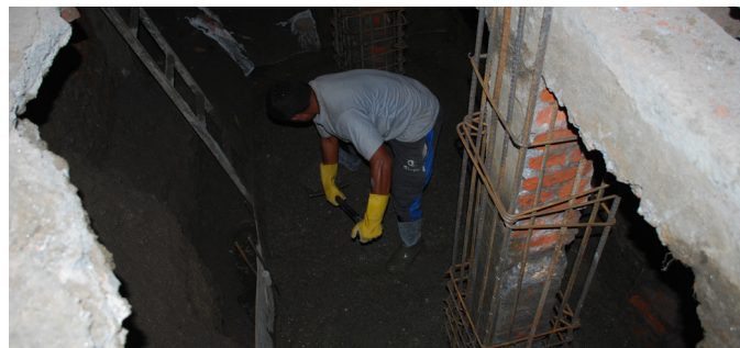
Styrker fundamentet
