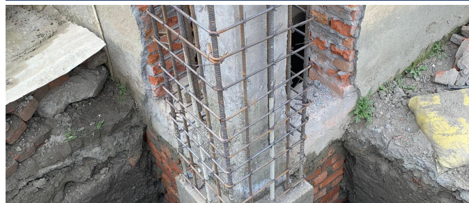
Styrker og dobler størrelsen på pilarene
