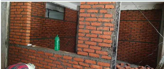
Bygger murvegger, med ekstra jordskjelvsikring
