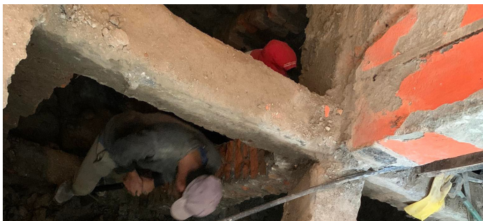
Graver ned til grunnmuren
